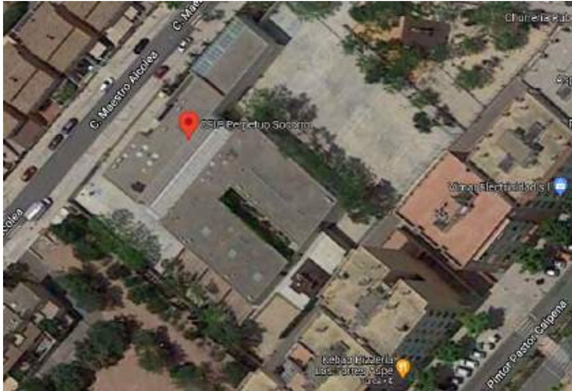
Vista aérea instalaciones
