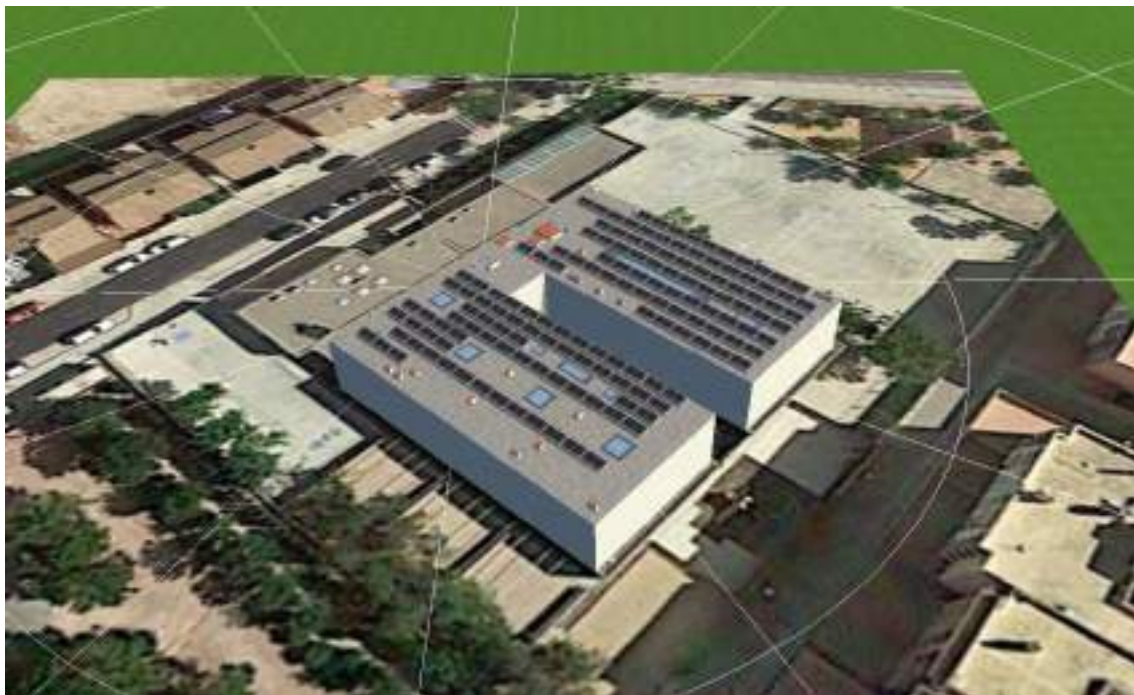
Foto 6: Vista sur de la instalación
