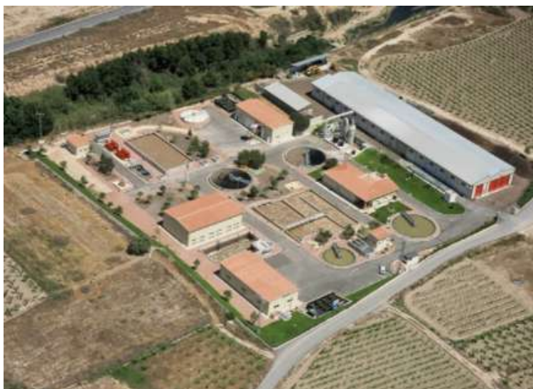
Imagen 4: Procesos y EDAR de Aspe. Fuente: EPSAR.
