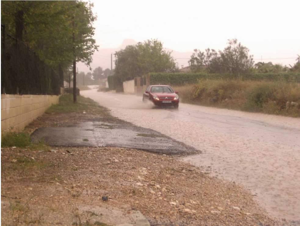
Foto: El Camino Viejo del Hondón hace igualmente de cauce, bajando a través de él la escorrentía superficial. Los coches circulan por la parte central del camino que es el único sitio transitable.
