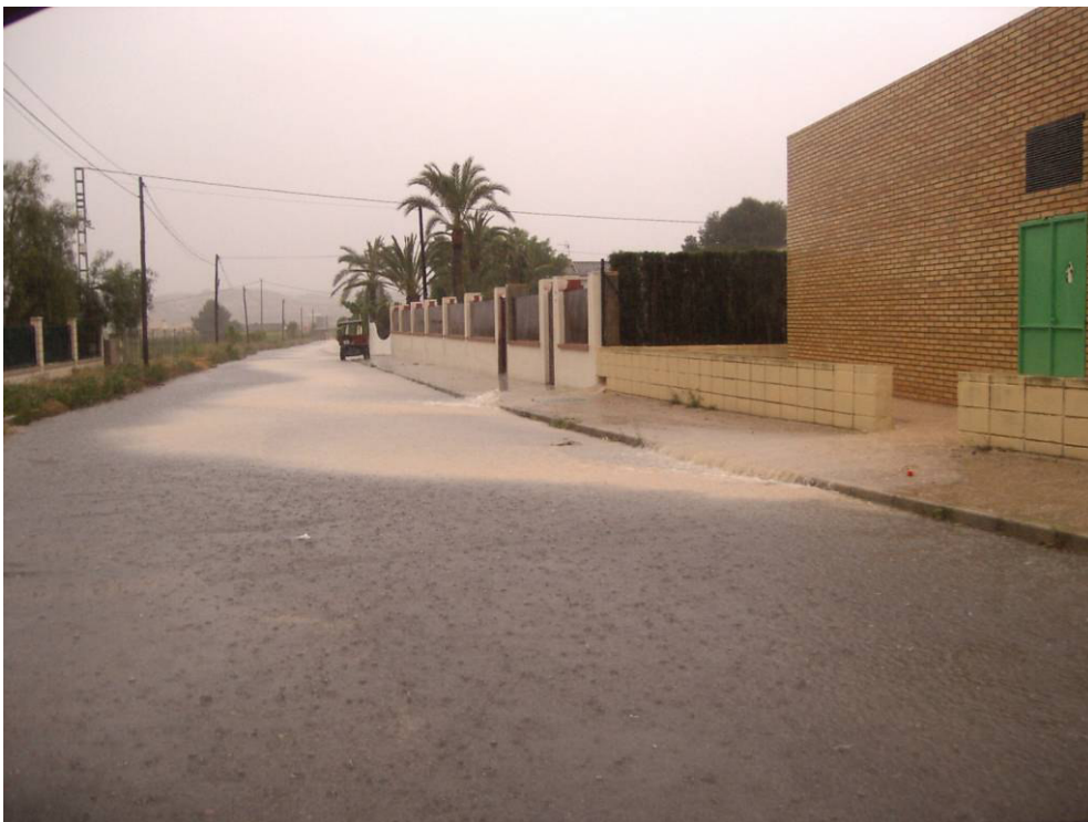
Foto: Camino de acceso al polideportivo, mirando hacia aguas abajo, que hace también de rambla incluso para lluvias reducidas.
