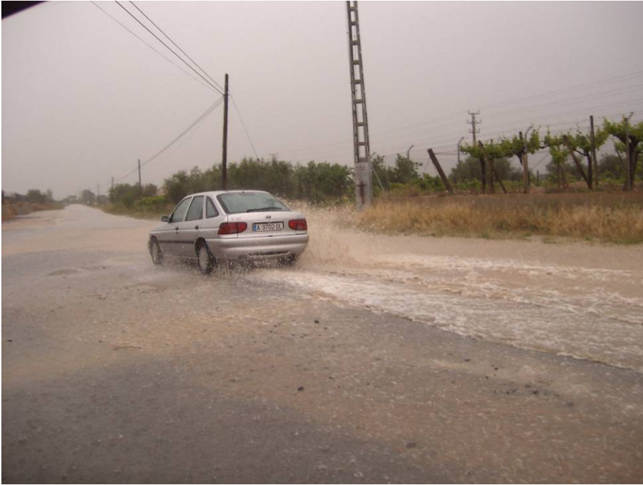
Foto: Cruce del Camino Viejo del Hondón con el hipotético curso de agua procedente de la Rambla de la Romana y del Barranco de las Delicias, punto situado aguas arriba de la reaparición de cauce del Río Tarafa, mirando hacia aguas abajo. La inexistencia de obras de drenaje hace que el flujo circule sobre el camino.
