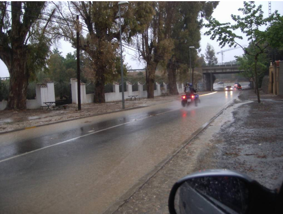
Foto: A través del Camino de la Romana circula también un cierto caudal en superficie para periodos de retorno reducidos. Bajo el puente el agua se encharca, aunque desagua hacia su margen izquierda buscando el cauce del Río Tarafa.
