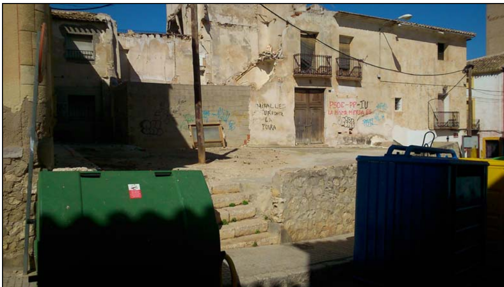
4.- Vista del espacio libre elevado llamado “El Calvario” o “Los Banquicos” sobre el que no se actúa. Solamente se soterran y elimina la línea aérea de telefónica.
