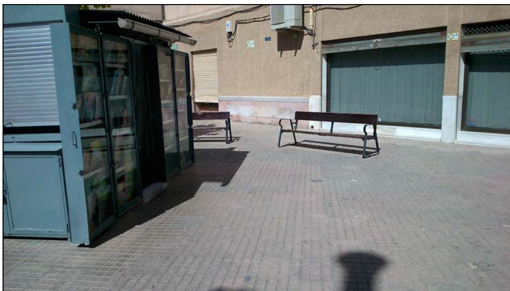
18.- Detalle de espacio detrás del kiosco. Existencia de mobiliario urbano obsoleto y en estado deficiente.
