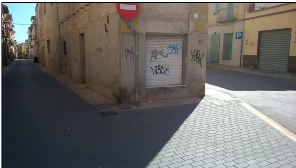
7.- Detalle de la salida de la calle Concepción a la calle Ramón y Cajal. Detalle de adoquín, losa de borde, y registros de instalaciones.
