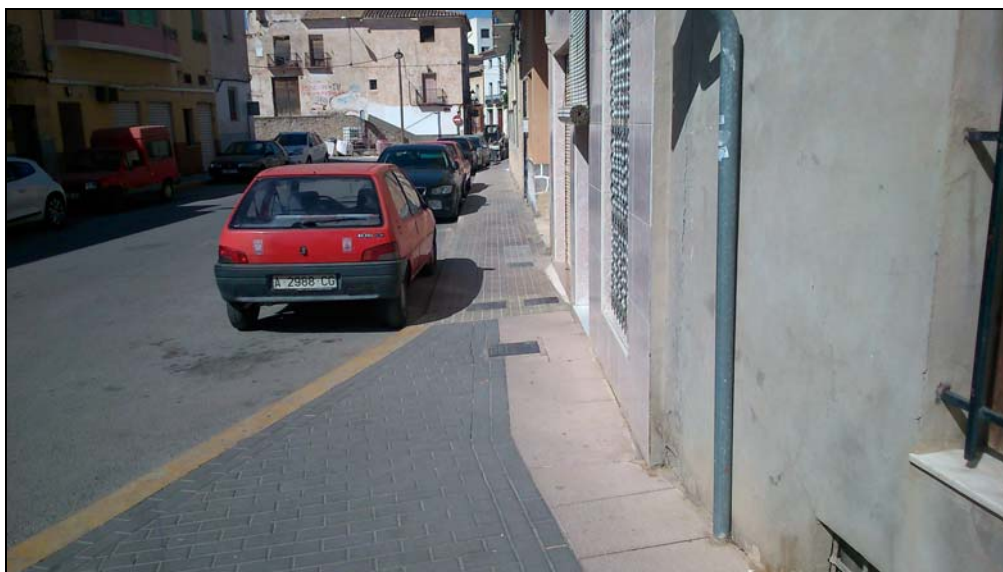
8.- Vista de la reducción actual de acera de la calle Concepción a la calle Ramón y Cajal. Detalle de registros de instalaciones de alumbrado y agua potable. Detalle de poste de sustentación de sección circular en señalización vertical.
