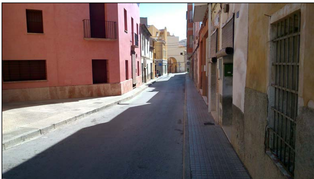
20.- Vista general del tercer tramo de la calle Ramón y Cajal. Se observa la estrechez de aceras que en algún caso ronda los 75 cm de anchura. Al fondo de aprecia la capilla de la calle Virgen de las Nieves.
