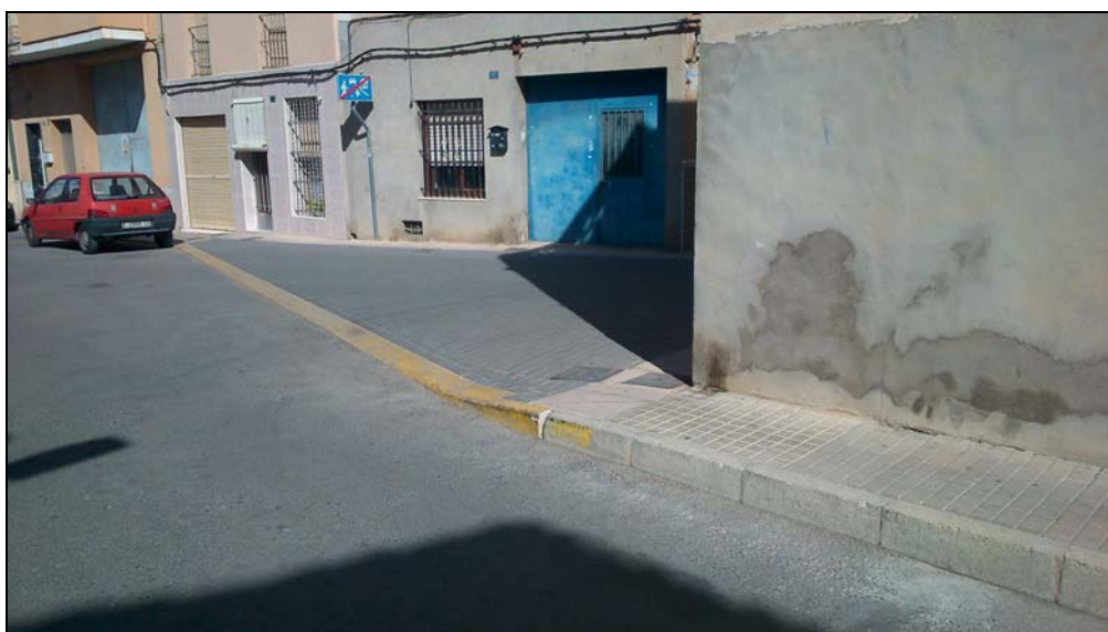
6.- Vista de la salida de la calle Concepción a la calle Ramón y Cajal vista desde ésta. Se observa el rebaje de bordillo y el pavimento de adoquín y losa blanca en borde que viene desde aquella.
