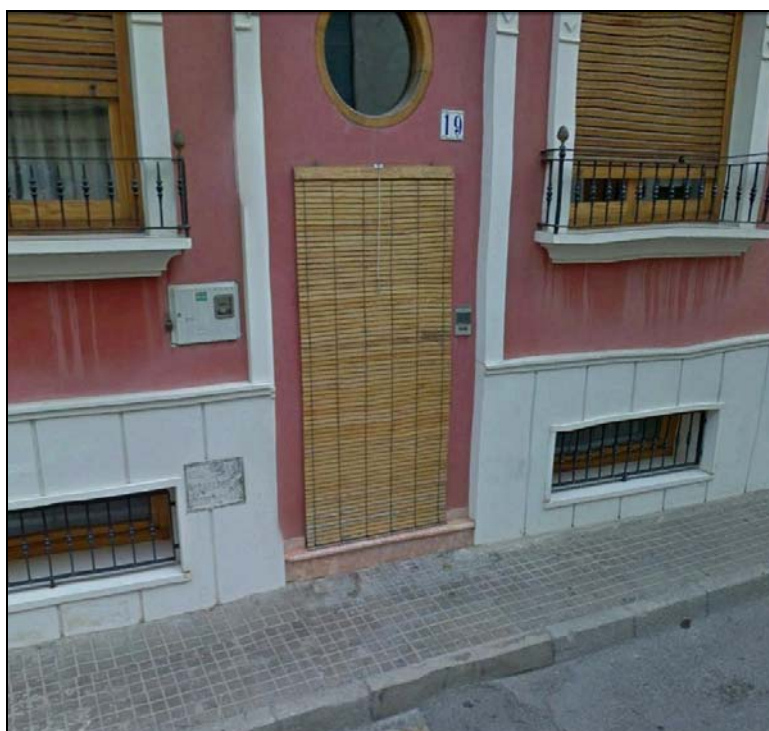
33.- Detalle de portal alto en el número de policía 19. Se aprecia también la ubicación de la acometida de saneamiento de la vivienda al igual que el contador de agua potable. Se observa con más detalle la calidad de pastilla en acera, su estrechez y el tipo de bordillo erosionado existente.
