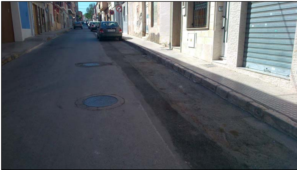
3.- Detalle de las canalizaciones de Telefónica y Gas existentes a lo largo de la calle Barítano Luis Almodóvar y que afecta al tramo inicial de la calle Ramón y Cajal.
