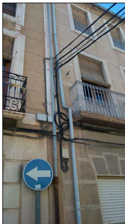
14 y 15.- Detalle de cruce aéreo de Iberdrola Telefónica y alumbrado público. Todos ellos a soterrar. Localizado en la esquina de la calle Ramón y Cajal y Concepción (altura de número de policía 24).
