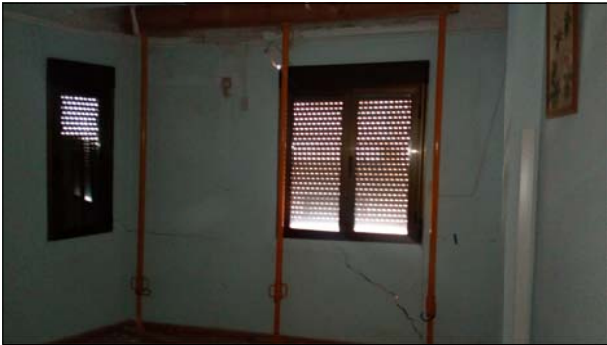
4.- GRIETA EN CERRAMIENTO DE FACHADA APUNTAMIENTO
