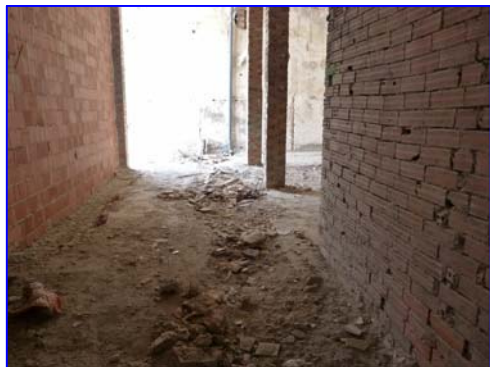
12.-SANEAMIENTO ENTERRADO, DETERIORADO Y CON FUGAS
