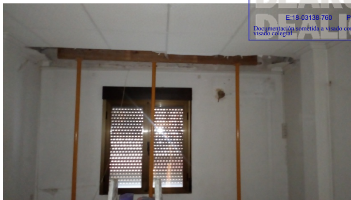
Apuntalamiento en zona interior de voladizo.
