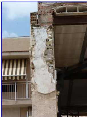
7.- DESCONCHADO, FISURAS Y DESPLOME DE MURO MEDIANERO
