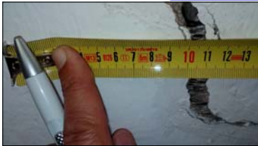
4.- GRIETA EN CERRAMIENTO DE FACHADA APUNTAMIENTO
