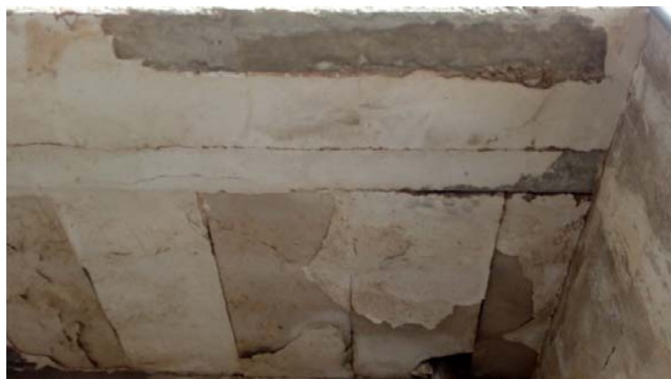
Viguetas con aluminosis, flechas y bovedillas rotas.
