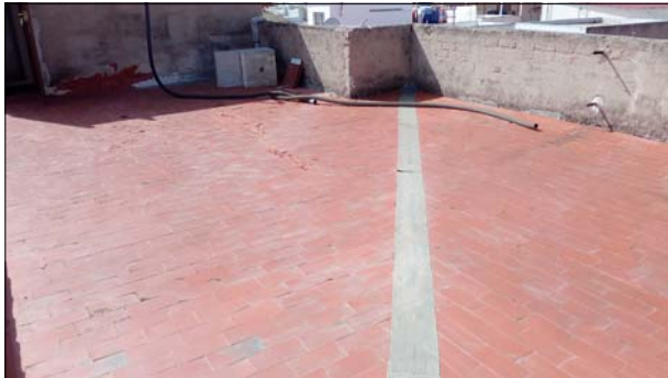
2.- CUBIERTA PLANA SIN IMPERMEABILIZACIÓN
