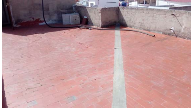
Aspecto de la cubierta plana.
