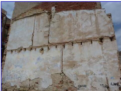
7.- DESCONCHADO, FISURAS Y DESPLOME DE MURO MEDIANERO
