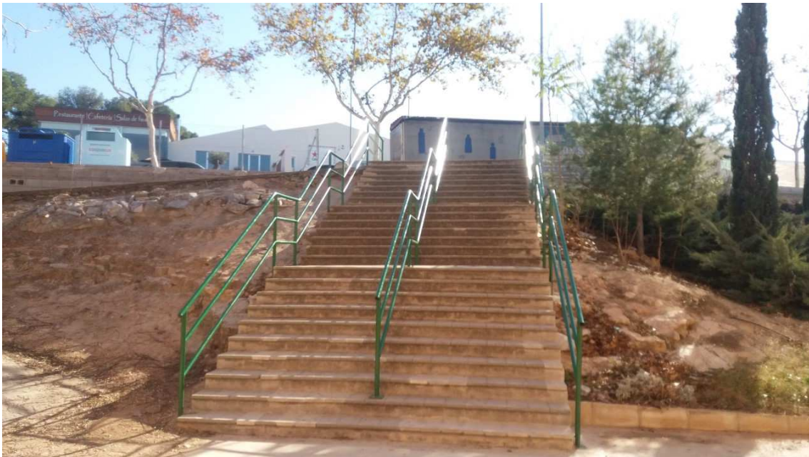
4.- Escaleras de acceso actual
