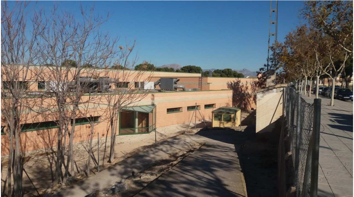
1.- Vista general de la zona (margen derecha acceso)
