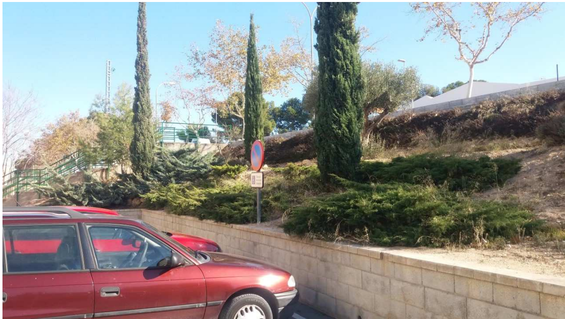
8.- Talud del desnivel existente
