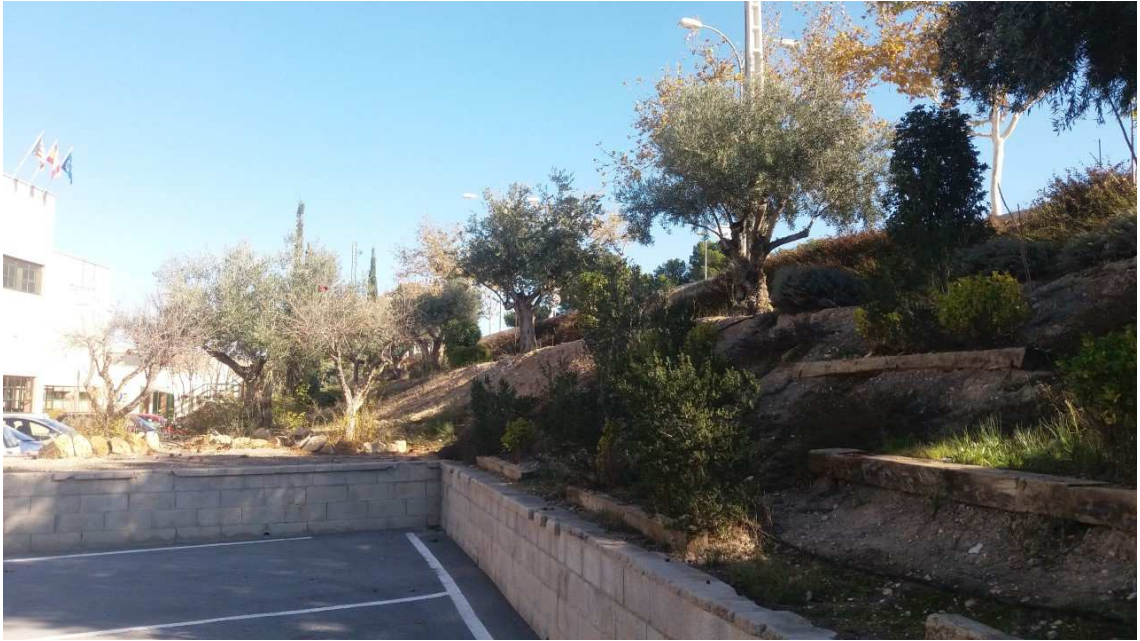
9.- Detalle del abancalamiento del terreno
