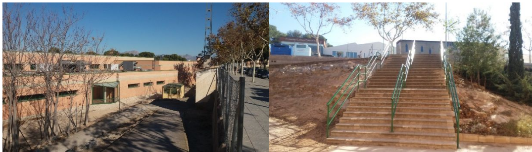
Imágenes Rampa y Escalera de acceso actuales
