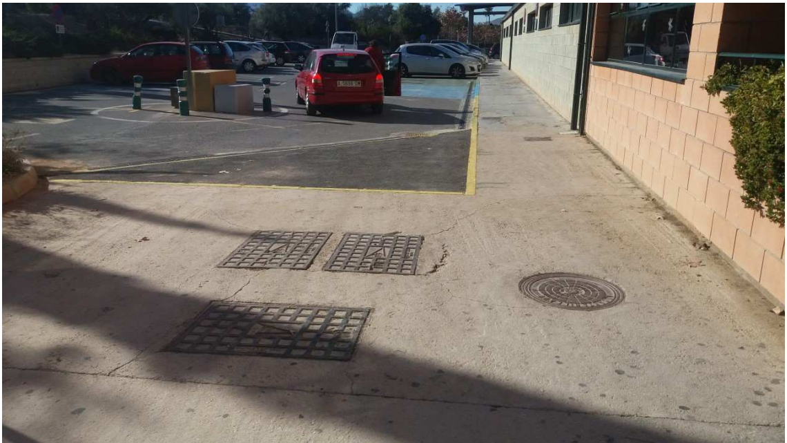
6.- Acera y registros en zona inferior de parcela
