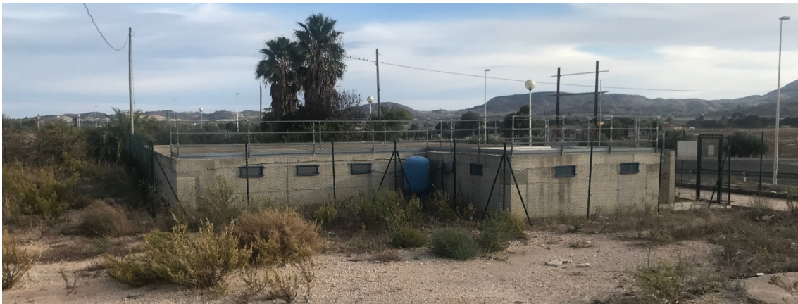
Vista del depósito de agua existente en la parcela Terciaría T2 a recalificar como dotacional
