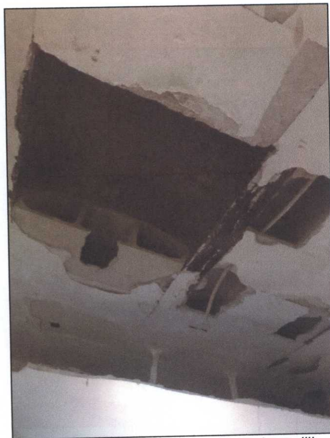
imagen. forjado de viguetas y bovedilla.
