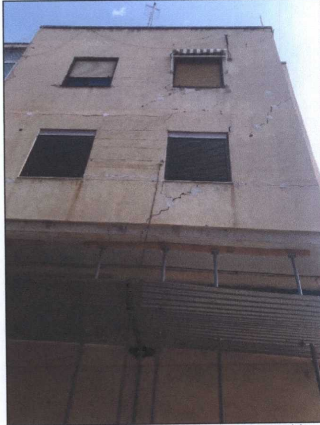
imagen. fachada principal del inmueble.
