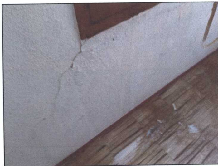
imagen. fisuras en ventanas
