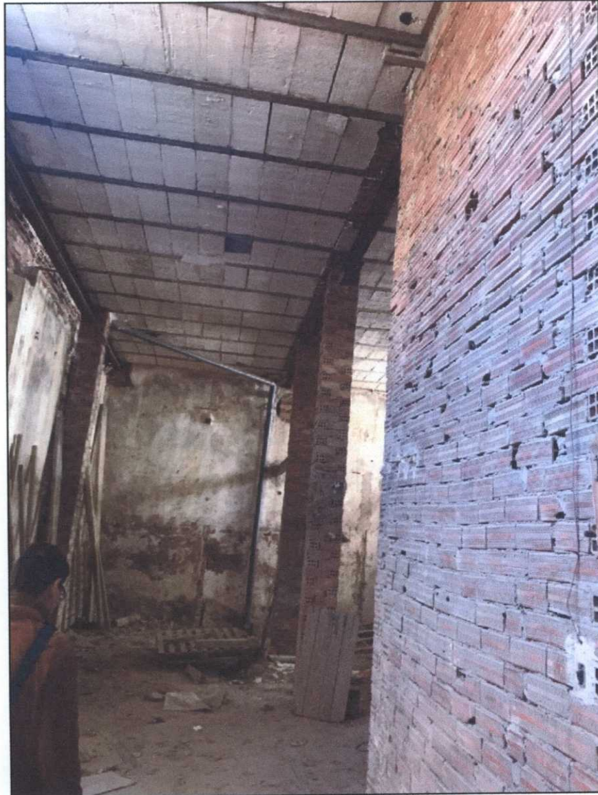
imagen. muros y pilares de fábrica de ladrillo
