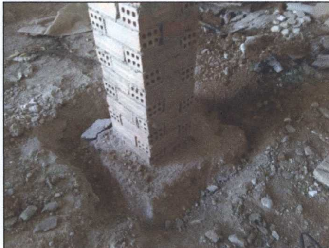
imagen. Cata en cimentación.
