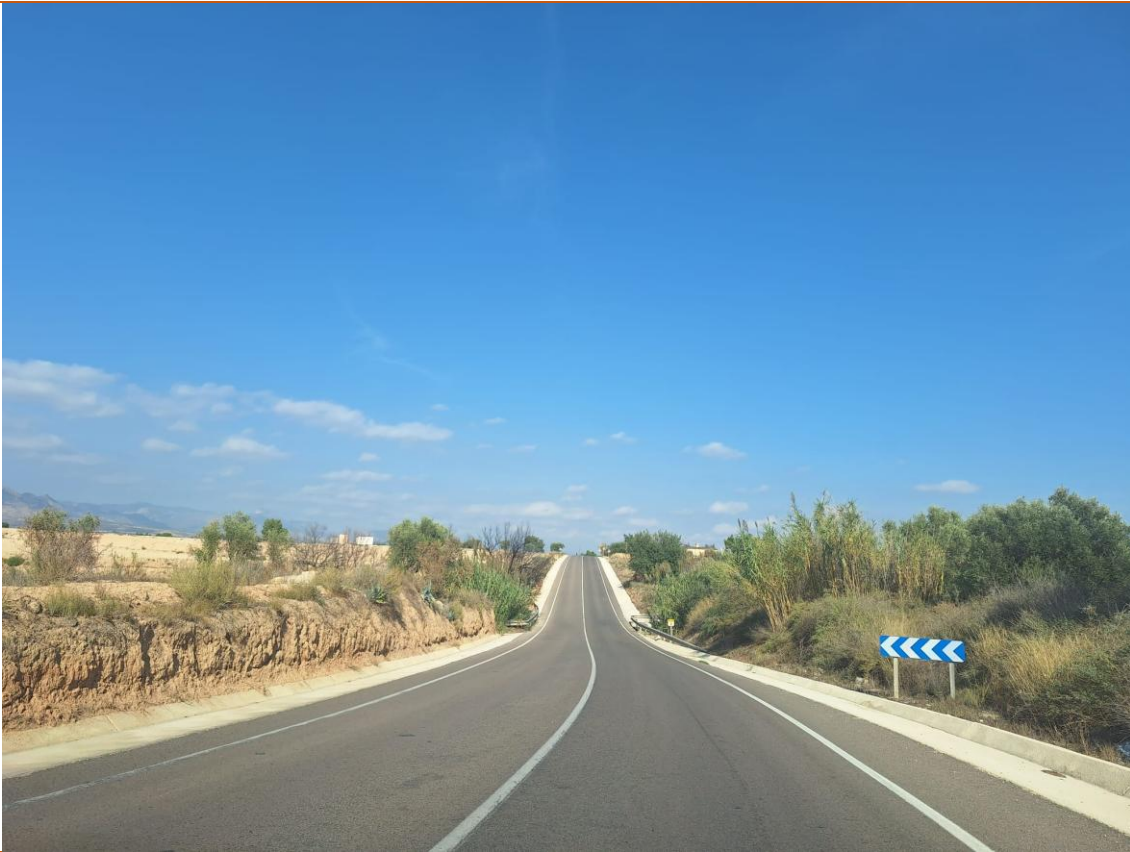
Vista del Baden en la CV-825 hacia el TM de Novelda, en el plano medio cruce de la rambla del Sastre a la izquierda y a la derecha de la vía confluencia con el río Tarafa
