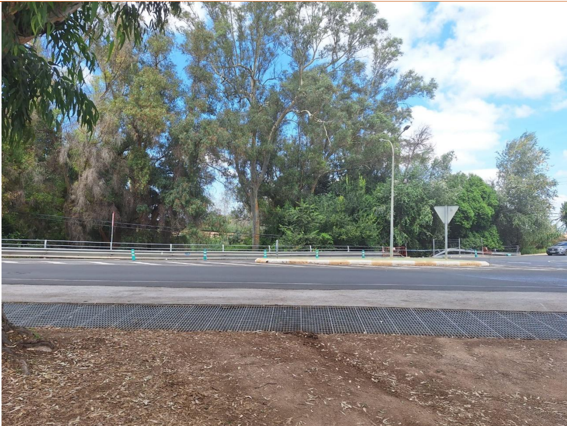
Imagen hacia la CV-846, en el primer plano se observa las trampillas de la canalización del río Tarafa
