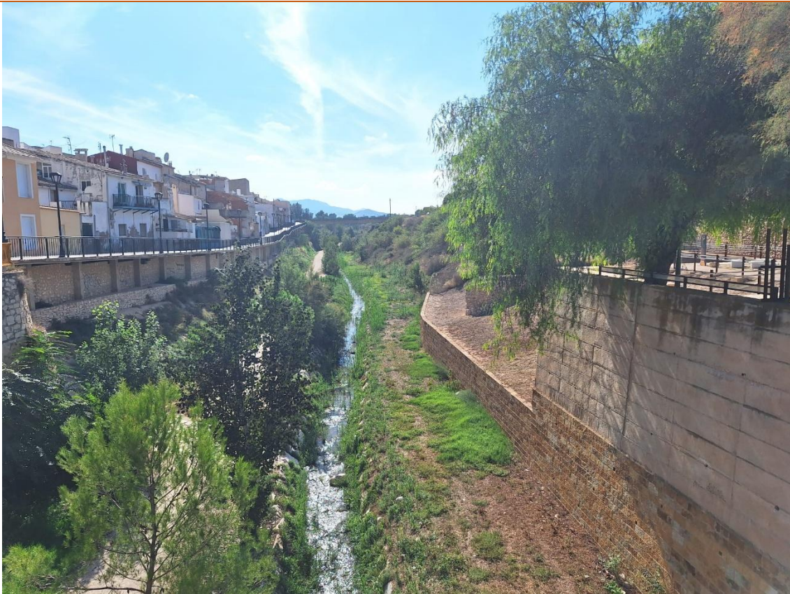
Imagen desde el Punto de Vigilancia Puente del Baño hacia el núcleo urbano de Aspe
