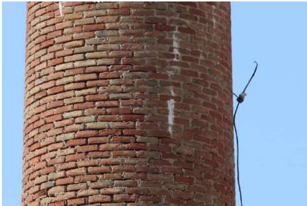
Fig nº 38 Aislador y fin de cable de puesta a tierra.
