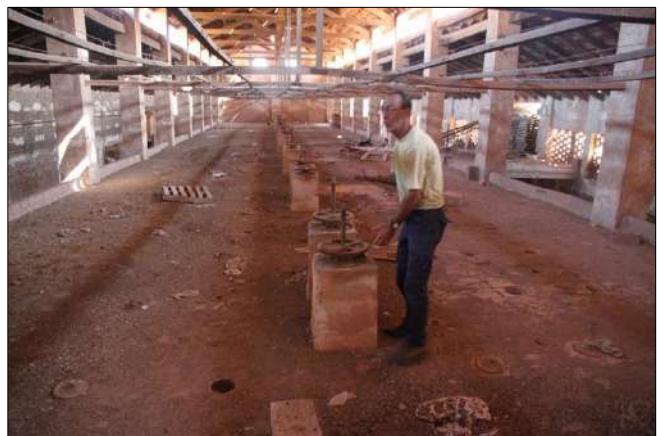
Fig nº 15. Forjado de techo del horno en Nave 1.
