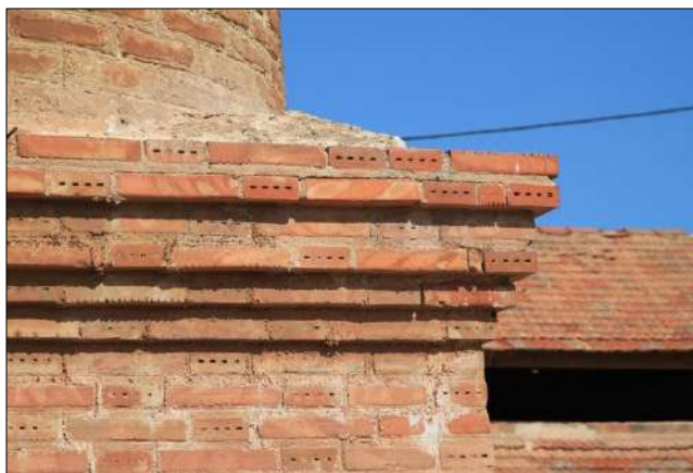
Fig nº 21. Cornisa de la base.
