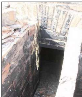
Fig nº 18 y 18 bis aclarada. Boca de entrada de humos y arqueta colindante.
