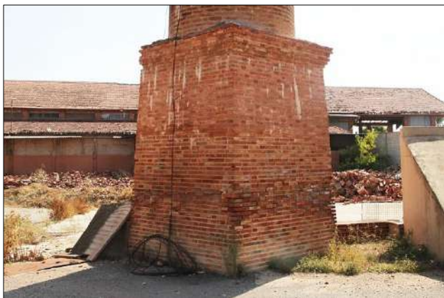
Fig nº 16. Base de la chimenea Santa Faz.
