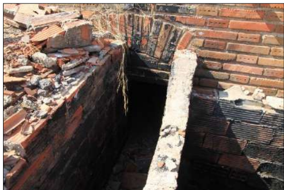
Fig nº 18 y 18 bis aclarada. Boca de entrada de humos y arqueta colindante.
