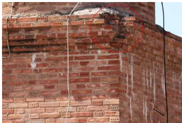
Fig nº 37 Desmoronamiento en cornisa de la base.
