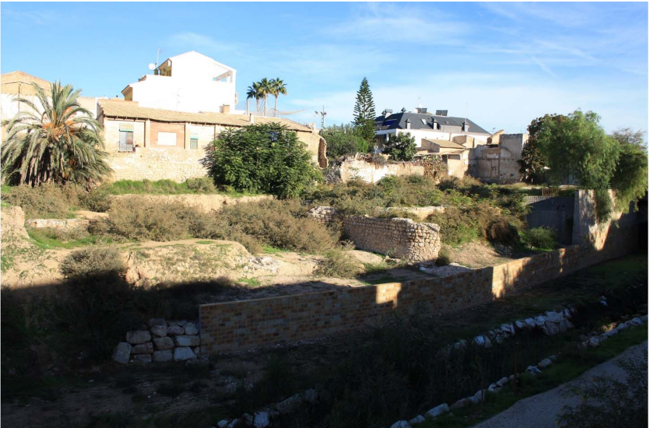
VISTA GENERAL DE LAS MURALLA DE MAMPOSTERÍA.
