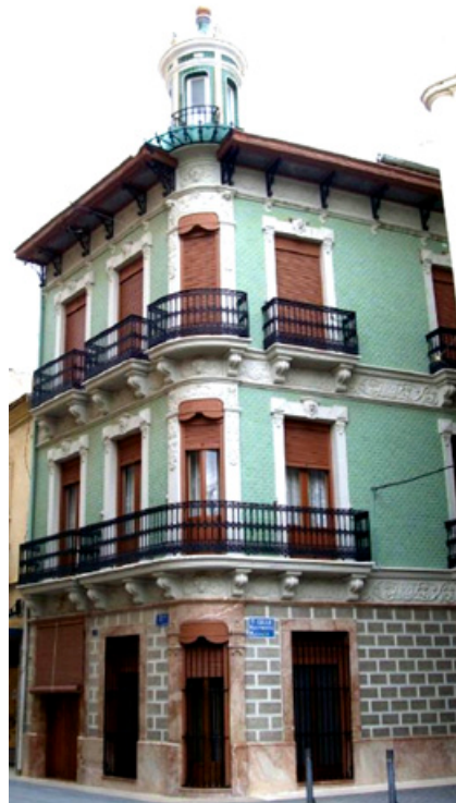
Casa del Pararrayos
